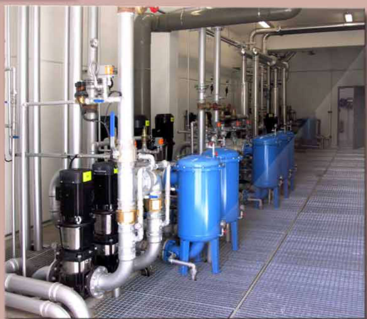
Sala de Bombas
